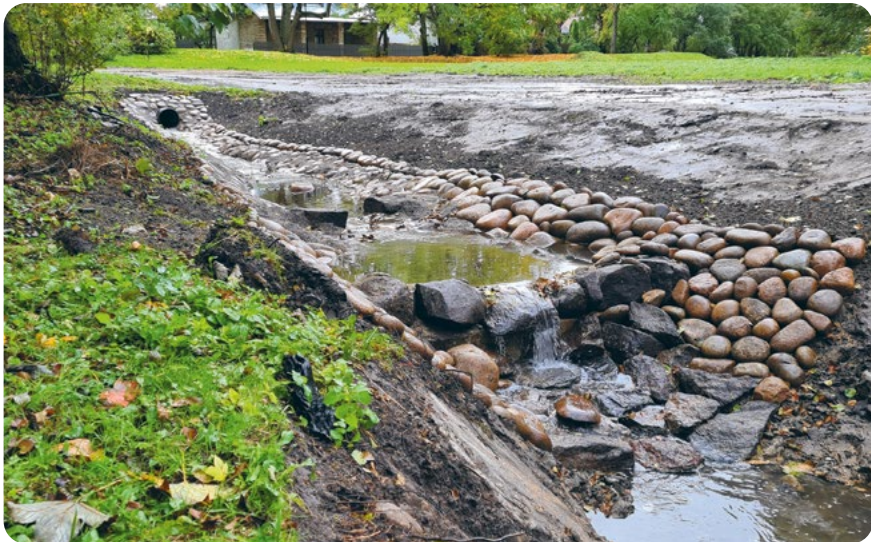
Foto 2. Sademevee sisenemise koht pargis paiknevasse kraavi, selle voolukiirust aeglustavad astekivid ja kosk. Foto: Taavi Valgmäe
