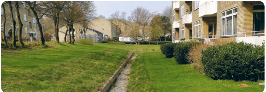
Foto 27. Täidisdreen kortermaja vundamenti kaitseks sõiduteelt valguga sademevee eest Taanis Kopenhaagenis. Foto: Gen Mandre
