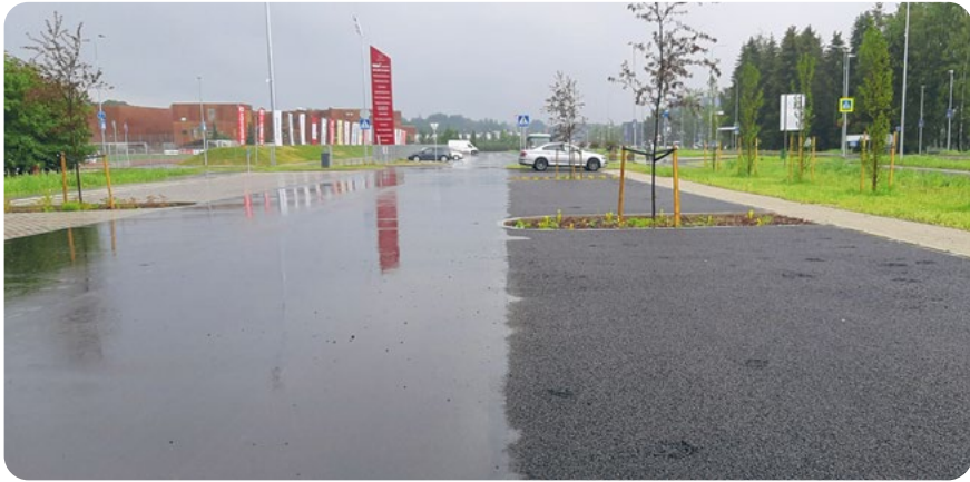
Foto 21. Dreenasfalt (paremal) ja harilik vett mitteläbilaskev asfalt (vasakul) vihmajärgel Viimsi vallas Haabneemel. Foto: Taavi Valgmäe
