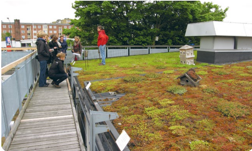
Foto 8. Ekstensiivne rohekatust Rootsisis Malmös. Foto: Gen Mandre
