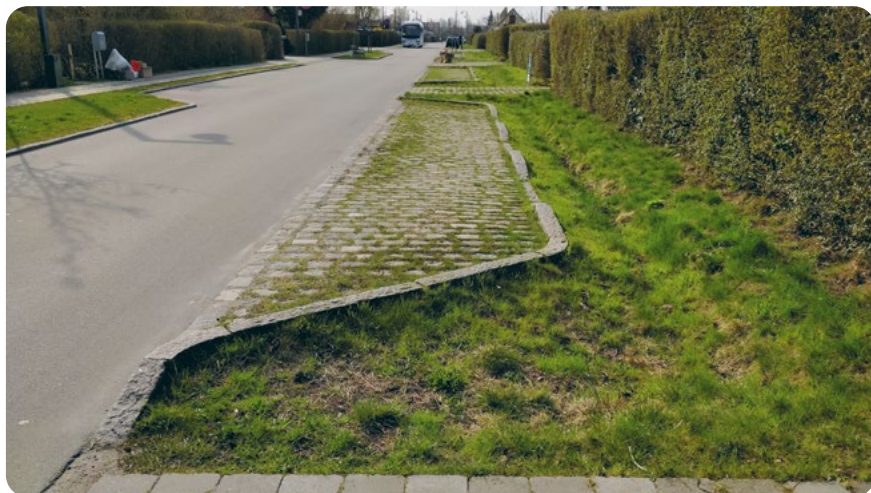
Foto 25. Vett läbilaskva katendiga parkimistasku Taanis Kopenhaagenis. Foto: Gen Mandre
