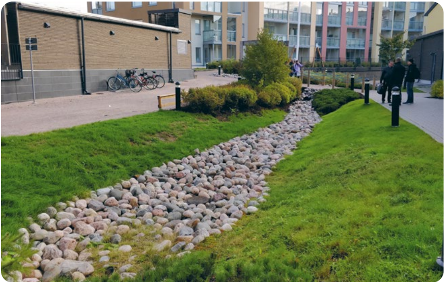
Foto 32. Voolukiirust aeglustavate takistustega (kivid) immutus- ja äravoolunõva Soomes Vantaas. Foto: Gen Mandre
