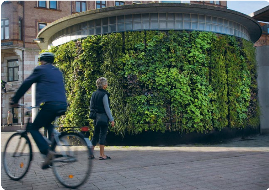
Foto 11. Roheseinaga kaetud pumphahoone Roots in Helsingborgis. Foto: Eva Lie
