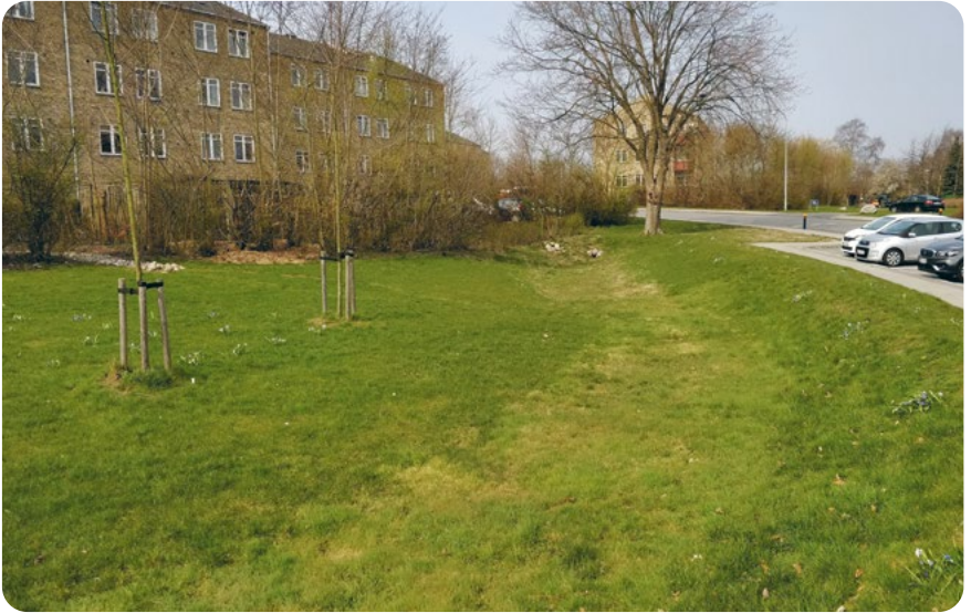
Foto 31. Kuiv filtratsiooninõva elumupiirkonna parkla ääres Taanis Kopenhaagenis. Foto: Gen Mandre
