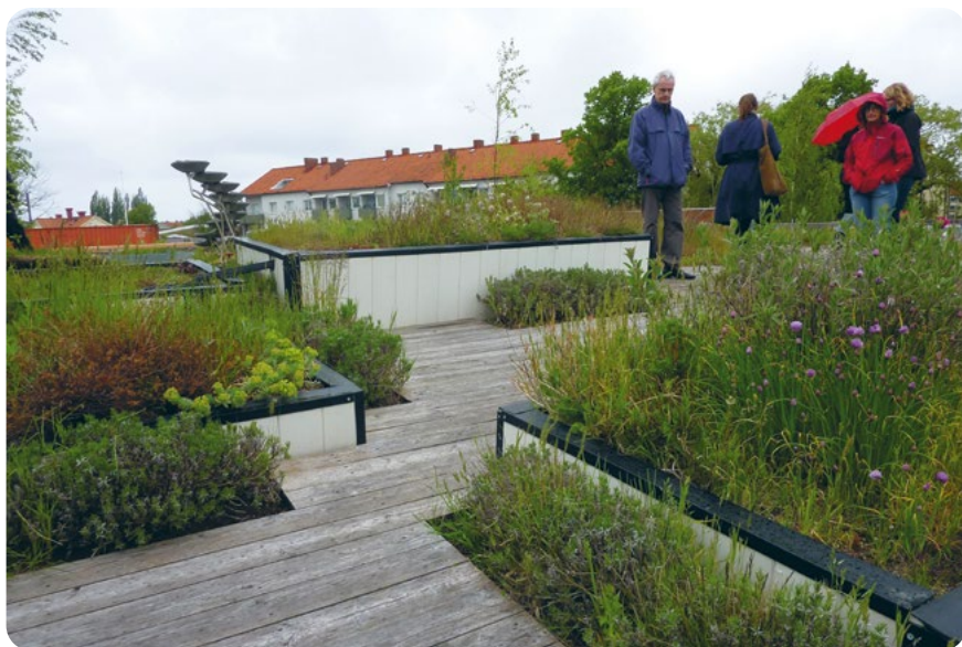
Foto 10. Konteinerhaljastusega rohekatus Rootsis Malmös. Foto: Gen Mandre
