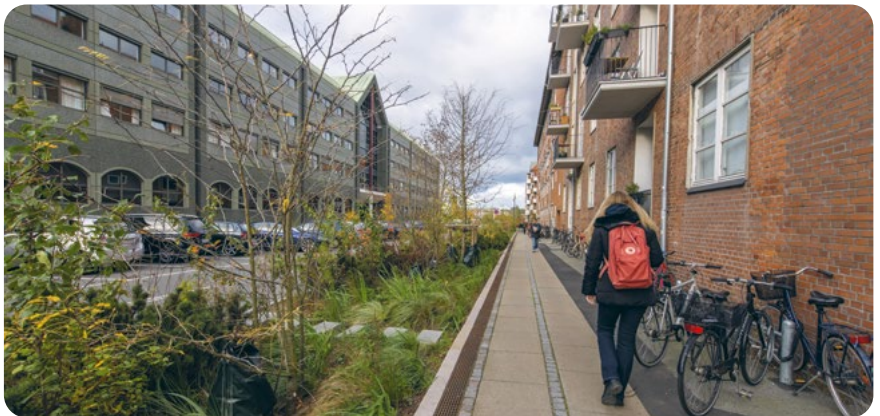
Foto 35. Kõnni- või jalgrattateed sõiduteest eraldav lineaarne vihmapeenar Taanis Kopenhaagenis. Foto: Kopenhaageni Linnavalitsus
