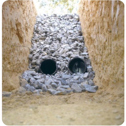
Foto 29. Imbkraavi rajamine. Allikas: Wikimedia Commons ( www.commons.wikimedia.org/wiki/File:FrenchDrain-02.jpg )
