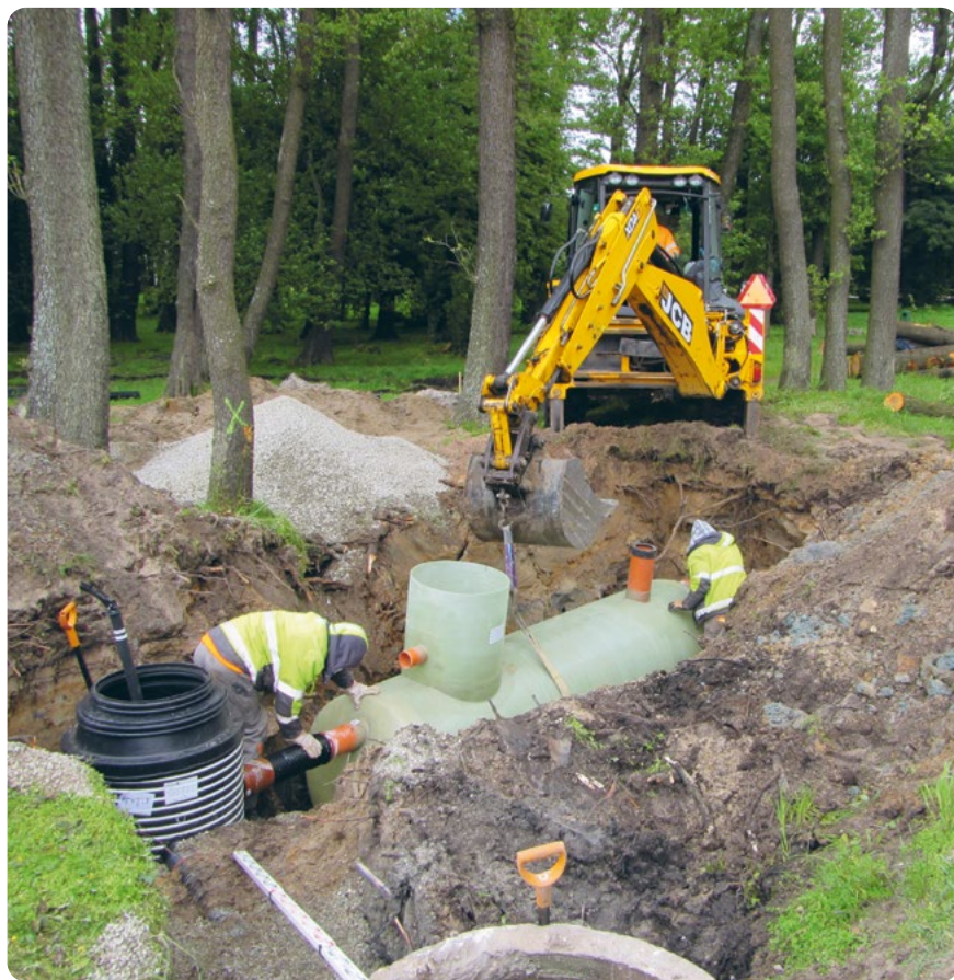
Foto 46. Liiva-mudapüüduuri paigaldamine Viimsi vallas Haabneemes. Foto: Taavi Valgmäe
