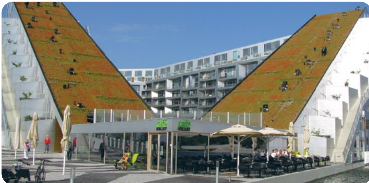
Foto 7. Ekstensiivne rohekatuse järgemata kaldega katusel Taanis Kopenhaagenis. Foto: Gen Mandre
