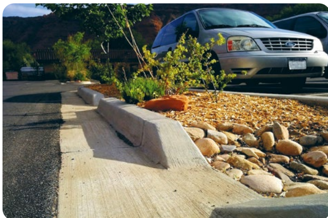
Foto 34. Sissevool on soovitatav projekteerida siseneva vee kiirust aeglustavana. Selleks võib kasutada mitmesuguseid takistusi. Allikas: www.permaculture.org
