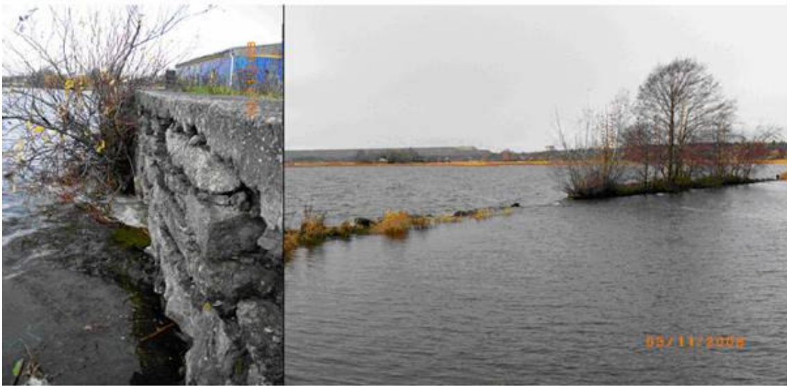
Joonis 4.1. Kulgu sadama lagunev sadamakai (vasakul) ja osaliselt sadama lainemurdja funktsiooni täitev maariba (paremal). Allikas: OÜ Alkranel, 2008.
