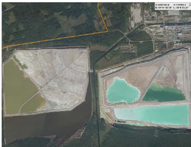
Foto 2. Balti soojuselektrijaama tuhaväljad Narva edelaosas.
